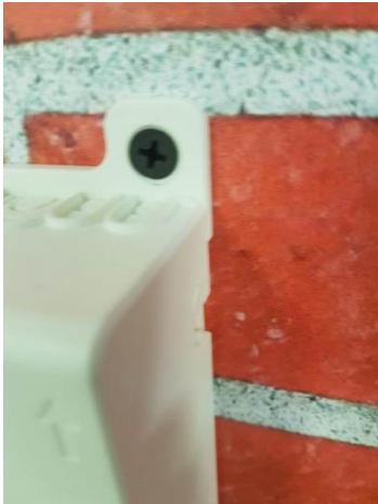
Fot. 1 - zamontowana obudowa mufy KLD-BOX-F.
